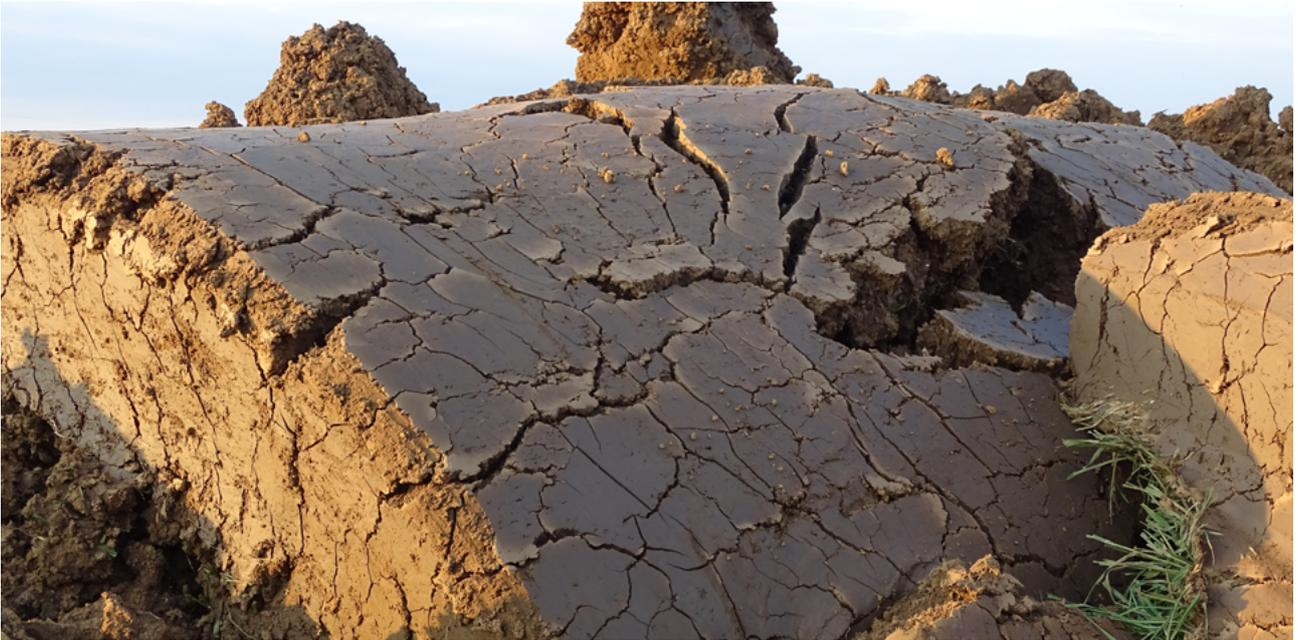
Walzenbildung und Gefügeschädigung durch schiebenden Abtrag bei Nässe
