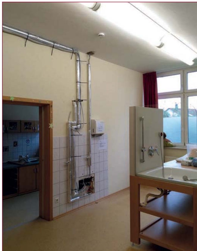
Auch in der Kinderkrippe im Schulgebäude wurden neue Wasserleitungen verlegt.
