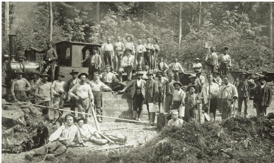
Zum Bau der Bahn wurde eigens eine Feldbahn eingerichtet. Auf dem Bild posieren die Arbeiter vor der kleinen Lok „Maria“.
